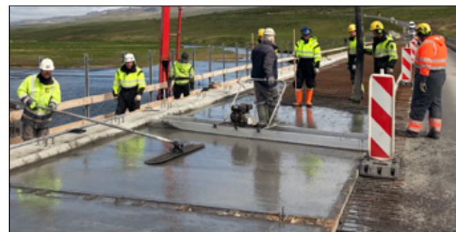
Nýtt brúargólf steyppt 19.06.2018..
