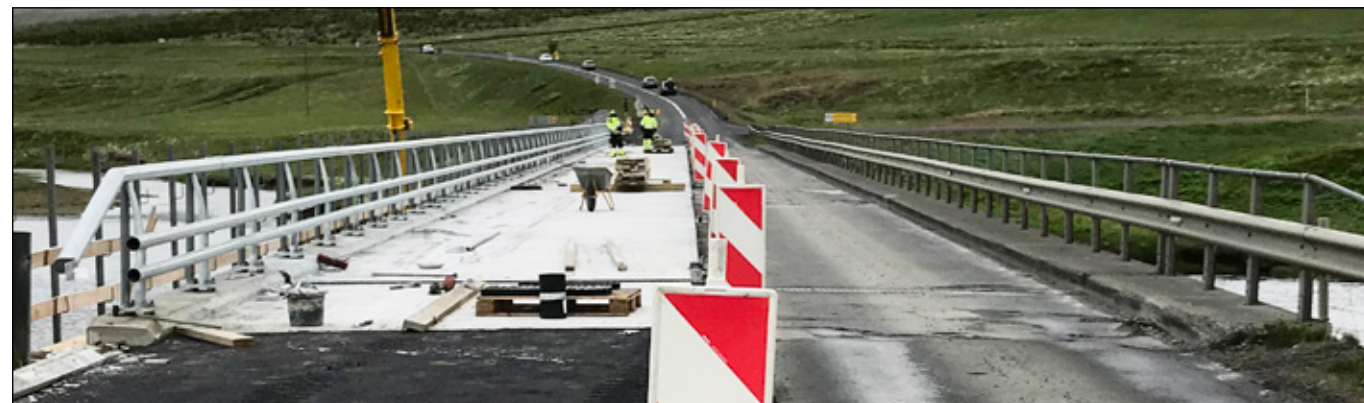
Fyrri áfangi viðgerðar að verða tilbúinn 22.06.2018. Vel sést hver munurinn er fyrir og eftir viðgerð.
