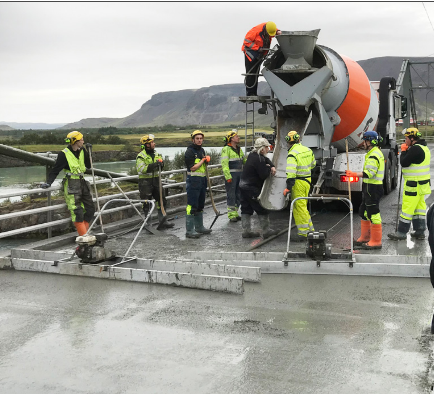
Steypuvinna á Ölfusárbrú. Mynd: Sigurður Hallur Sigurðsson.
