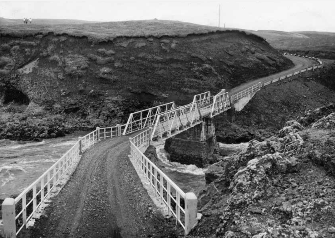
Mynd 7. Brúin sem byggð var 1919-20 í stað þeirrar sem fór í Kötluhlaupinu 1918 séð til austurs. Í forgrunni er vegurinn á garðinum eða rímanum sem var við vesturbakkann áður en kom að landstöplinum. Sjá nánar gömlu stöplana á mynd 8. Myndasafn Vegagerðarinnar Jón J. Víðis.
