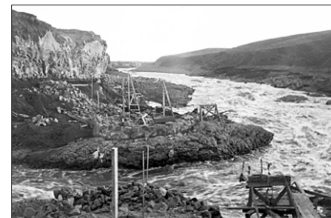
Mynd 5. Horft upp eftir farveginum af austur bakkannum sennilega árið 1919 (frekar en 1920) þegar unnið var við endurreisn brúar og verið að koma upp landstöpli að vestan og hefur neðstu steinarröðinni verið komið fyrir á klöppinni á miðri mynd. Glöggst sést hversu mikið hefur brotnað úr bakkannum að baki stöplinum. Ekki sést í klettanabbann í farveginum sem er í hvarfi við bakkann að austan (nær á mynd). Myndasafn Vegagerðarinnar Geir G. Zoëga.
