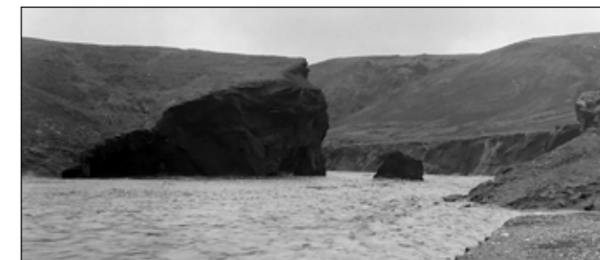
Mynd 4. Afleiðingar Kötlugosins og hlaupsins 12. okt. 1918. Myndin er tekin af austur bakkannum upp eftir farveginum rétt neðan en þar sem brúin frá 1907 var, en er þarna með öllu horfin. Úti í ánni er eftir klettanabbi sem var vafalaust leifar af þeim stað þar sem millistöpull/áseta hafði verið. Í bakkannum vinstra megin að vestan hefur átt sér stað mikið rof eins og sárið sýnir. Myndasafn Vegagerðarinnar Geir G. Zoëga.
