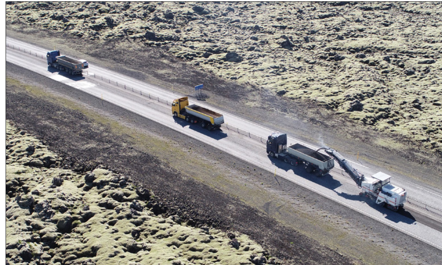
Hringvegur (1), Suðurlandsvegur, fræsing í Svínahrauni.
