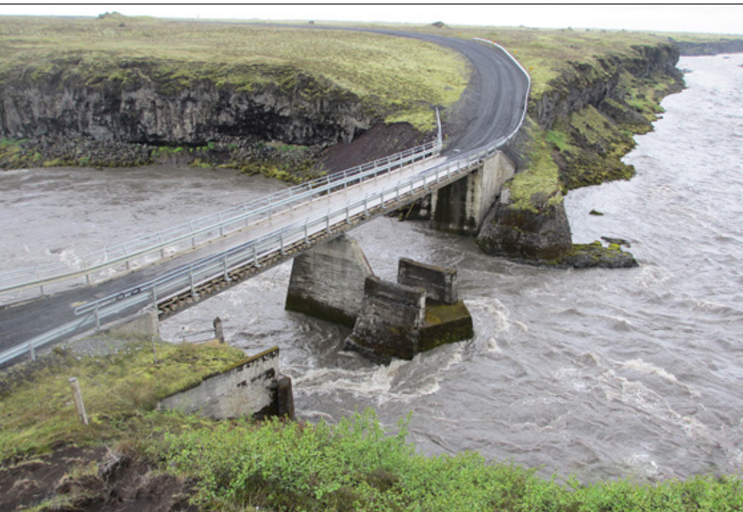
Mynd 8. Myndin tekin af austurbakkanum (gagnstætt mynd 5). Millistöpull brúarinnar frá 1920 sést framan við núverandi stöpul og á vesturbakkanum sést gamli landstöpullinn með hlaðna garðinum upp á bakkann og var í notkun til 1963 þegar núverandi brú þarna (sbr. mynd) tók við. Mynd höfundar 12. júní 2013.
